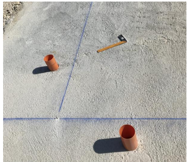
TRACCIAMENTO ASSE CON FILO TRACCIANTE Axis tracking with chalk string line reel level
